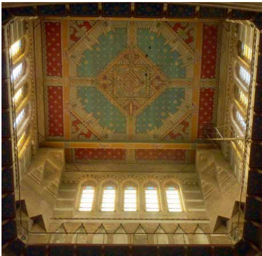
10 - Joseph Cuypers en Jan Stuyt, Laurentiuskerk in 't Ginneken (circa 1902). De hoofdstructuur van het hemels Jeruzalem met zijn doordachte symboliek. De sterk geprofileerde uitkragende hoekstukken lopen parallel met de vlak getekende 'stadsmuur' erboven, waardoor het vierkant overgaat in een achthoek.
