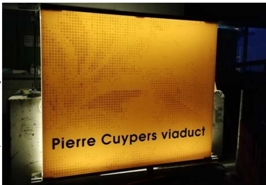
12 - Detail van de borstwering, gewijd aan Pierre Cuypers, ontworpen door Chris Spierings. Het effect van de verstrooiing van de pixels is duidelijk.
